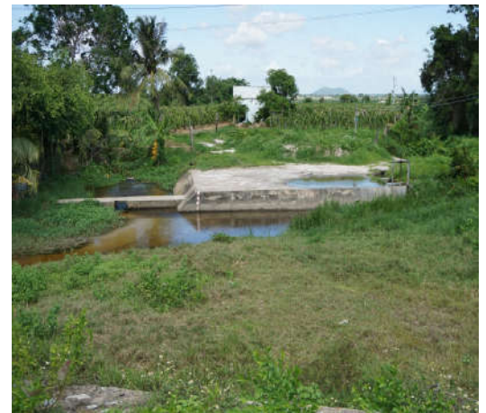
Hình 2.8: Đập Ba Khai hiện trạng trong khu vực dự án (hoạt động tốt)
