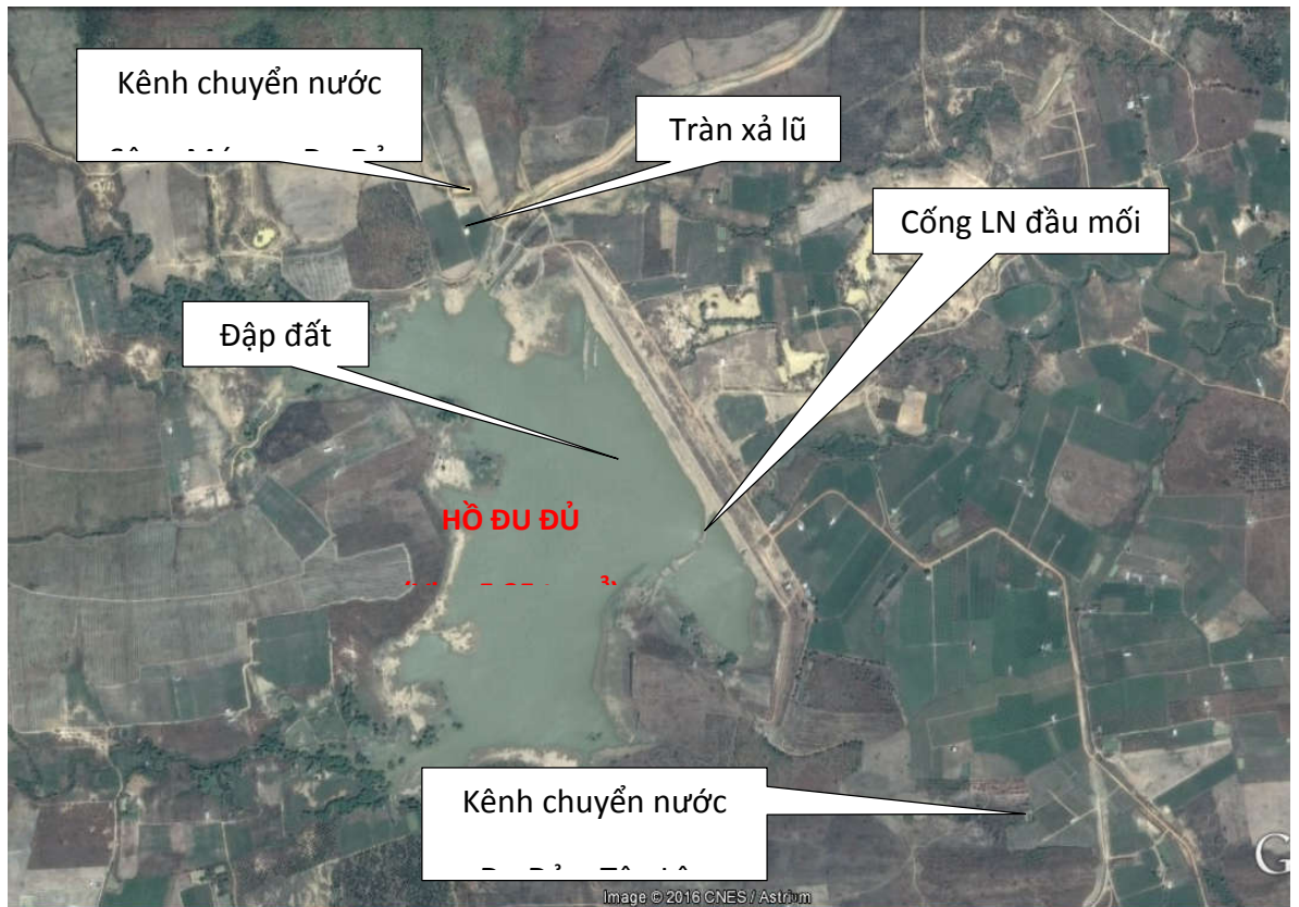
Hình 2.3: Hiện trạng công trình đầu mối hồ chứa nước Du Đủ (hoạt động tốt)
