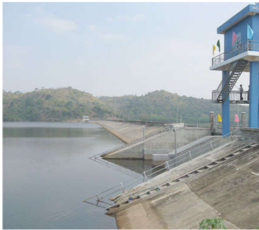
Hình 2.5: Hiện trạng công LN đầu mối hồ chứa nước Đu Đủ (hoạt động tốt)
